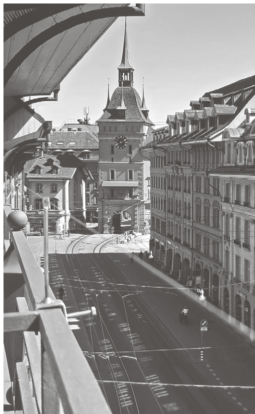
Vue depuis le bureau de la LITRA sur la Spitalgasse abandonnée.
