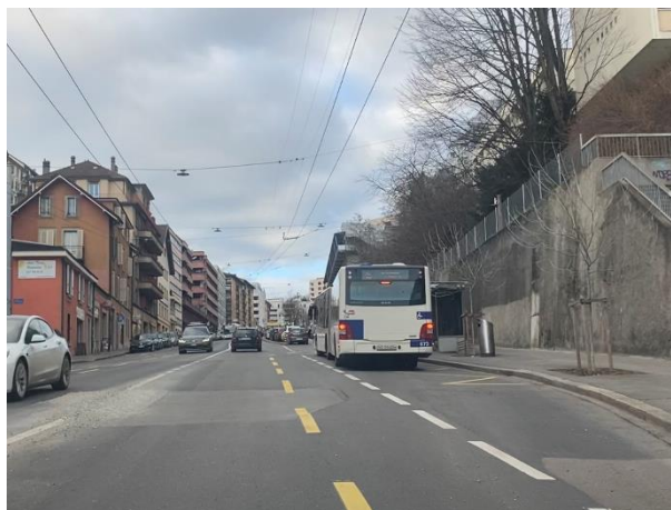
Figure 34 : Exemple de fente résiduelle due à la manœuvre d'accostage difficile
