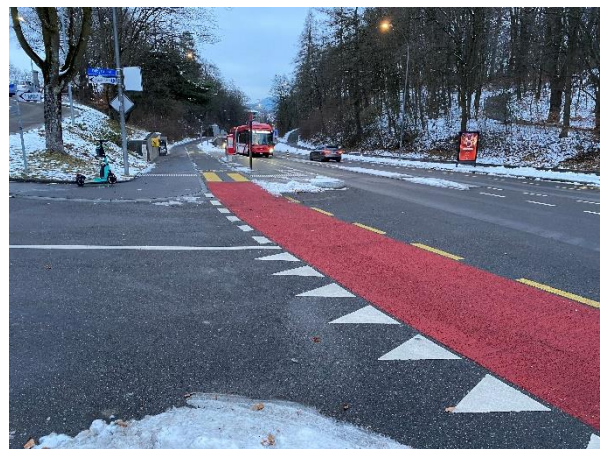
Figure 73 : Signalisation de la sortie du by-pass dans le sens Berne-Kôniz
