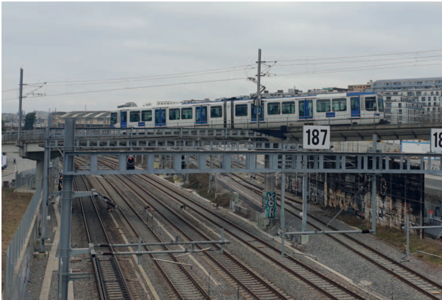
photo : métro M1 au-dessus du quartier de Sébeillon (2025) / source des auteurs
