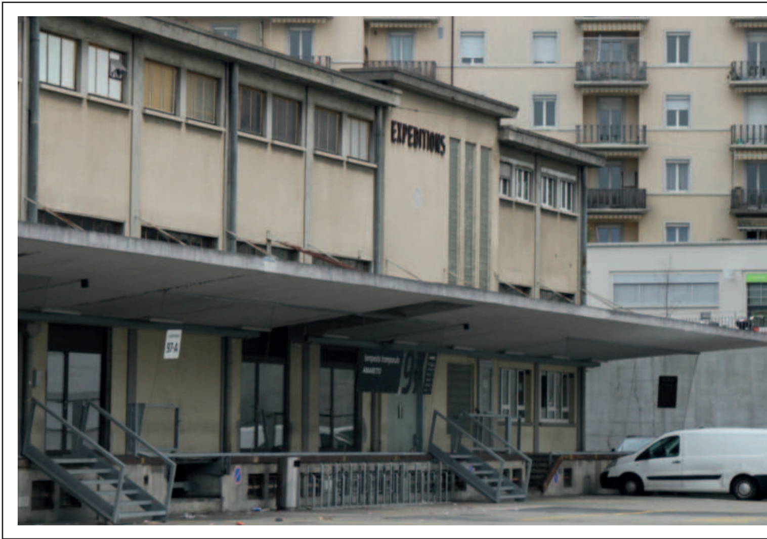
photo : ancienne halle de marchandises de Sébeillon (2025) / source des auteurs
