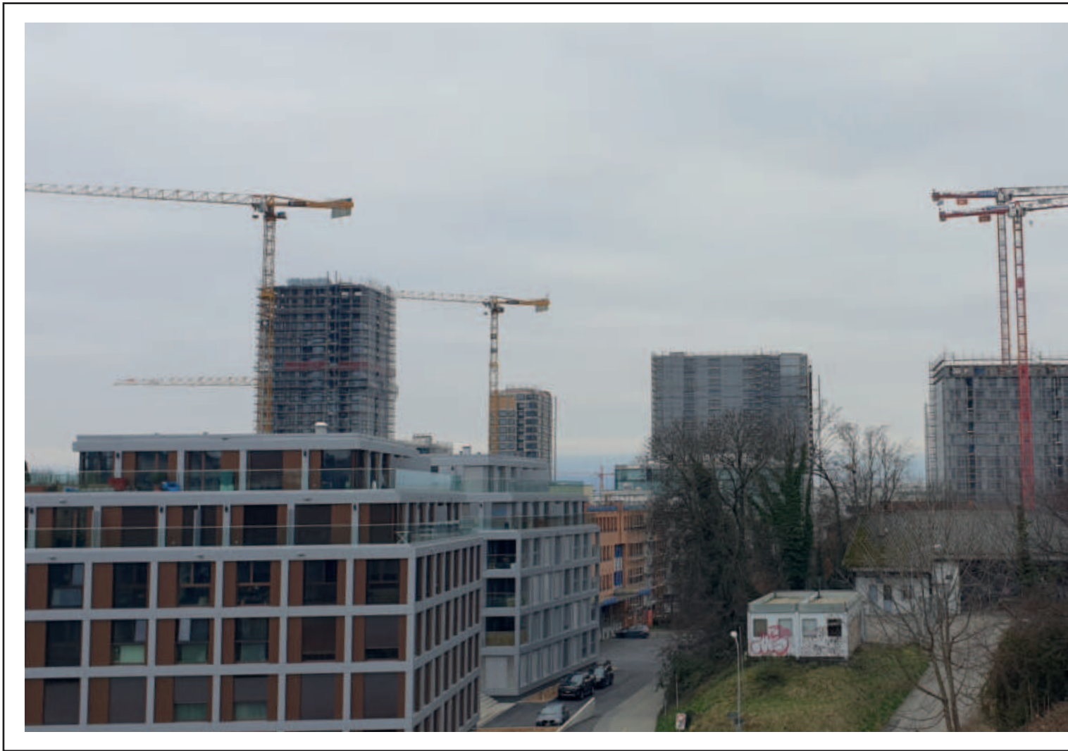
photo : chantiers de la gare et de quartier de logements de Prilly-Malley (2025) / source des auteurs
