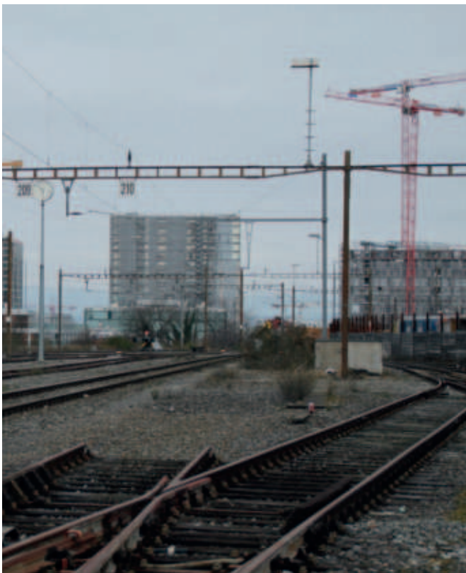
photo : faisceau de voies à Sébeillon (2025) / source des auteurs
