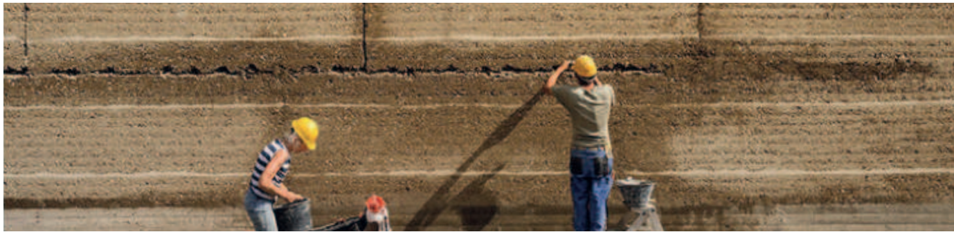
Façade en terre de pisé
