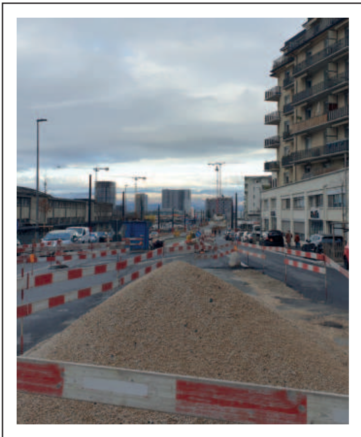
photo : chantiers de tram Renens-Lausanne (2025) / source des auteurs
