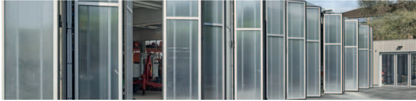
Parois vitrées mobiles, Illiz
