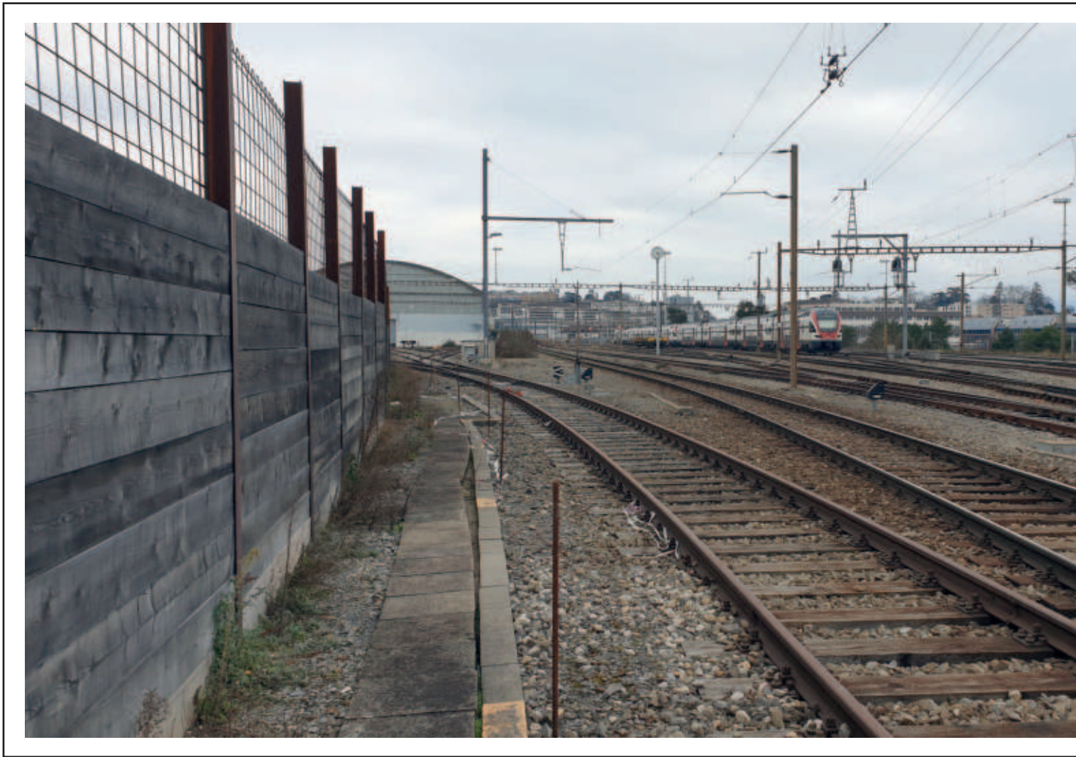
photo : plateau de Sébeillon et dégagement visuel sur le faisceau de rails (2025) / source des auteurs
