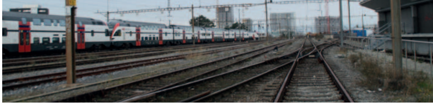
Faisceau de voies à Sébeillon
