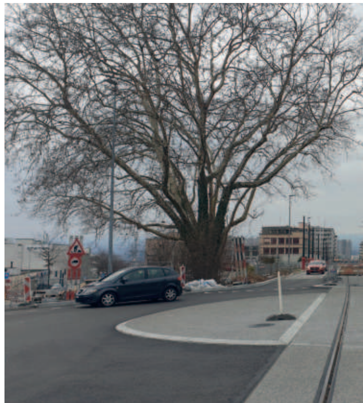
photo : chantier du tram Renens-Lausanne (2025) / source des auteurs
