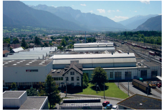
Abb. 9: RhB-Werkstatt Landquart: In Gebäuden liegen mehr Effizienzpotenziale als angenommen. (Quelle: RhB)
